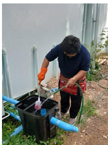
เจ้าหน้าที่และแม่บ้านล้างทำความสะอาดถังดักไขมัน
